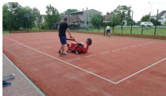
Obec Ostřetín Obnova sportovního hřiště Ostřetín
