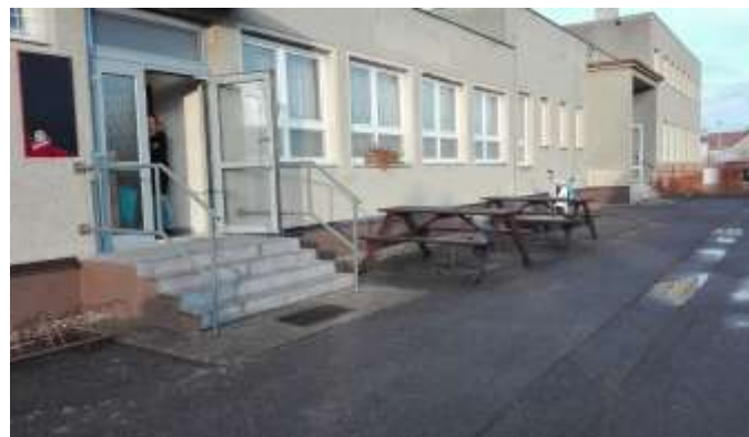
Obec Trusnov Oprava fasády na budovách kultur. zařízení
